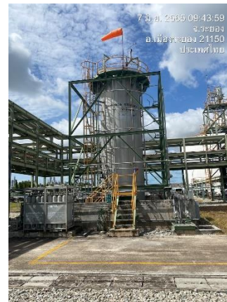
ภาพที่ 2-27 ถังเก็บสารละลายแอมโมเนียมไฮดรอกไซด์เหลว
