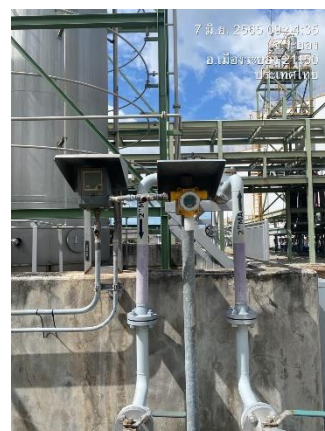
ภาพที่ 2-28 Gas Detector และ Ammonia Detector
