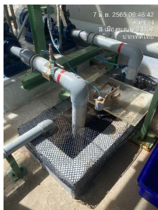
ภาพที่ 2-10 ถังปรับสภาพ (Neutralization Basin) (ใต้ดิน)
