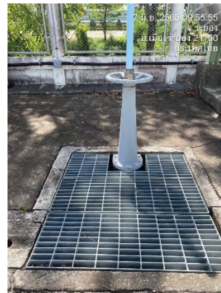
ภาพที่ 2-12 ประตูละบายน้ำทิ้งและน้ำฝนของโครงการ
