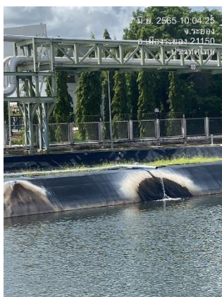
ภาพที่ 2-7 การเดินท่อและติดตั้งปั๊มเพื่อนำน้ำทิ้งจากกระบวนการผลิตมาใช้ใหม่
