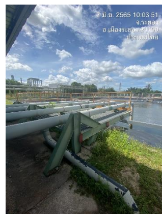
ภาพที่ 2-7 การเดินท่อและติดตั้งปั๊มเพื่อนำน้ำทิ้งจากกระบวนการผลิตมาใช้ใหม่
