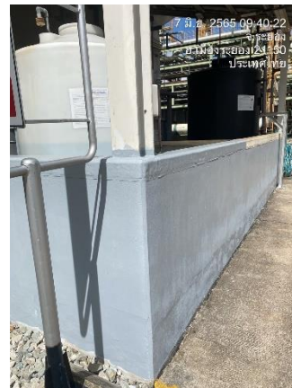
ภาพที่ 2-26 คันคอนกรีตป้องกันการหกรั่วไหลของสารเคมี
