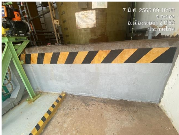
ภาพที่ 2-26 คันคอนกรีตป้องกันการหกรั่วไหลของสารเคมี
