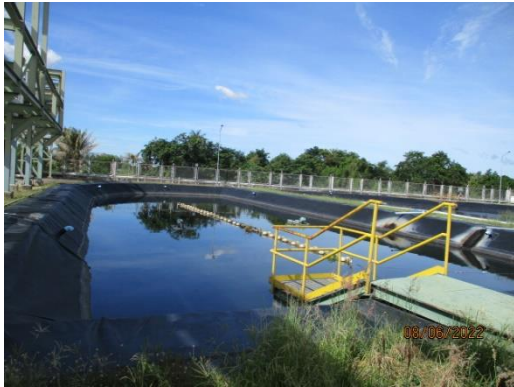
ภาพที่ 2-8 บ่อพักน้ำทิ้ง (Holding Pond)
