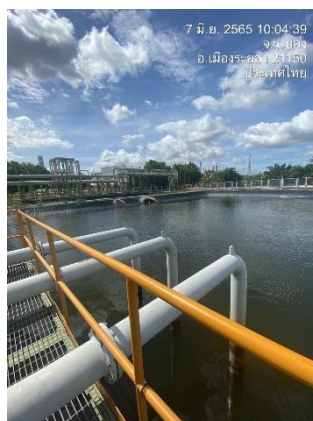
ภาพที่ 2-7 การเดินท่อและติดตั้งปั๊มเพื่อนำน้ำทิ้งจากกระบวนการผลิตมาใช้ใหม่
