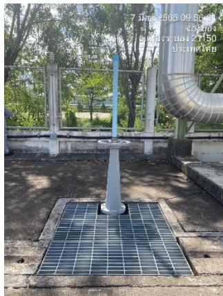
ภาพที่ 2-12 ประตูละบายน้ำทิ้งและน้ำฝนของโครงการ
